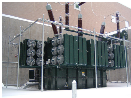
FIGURE 5.2 – Transformateur professionnel de haute tension
