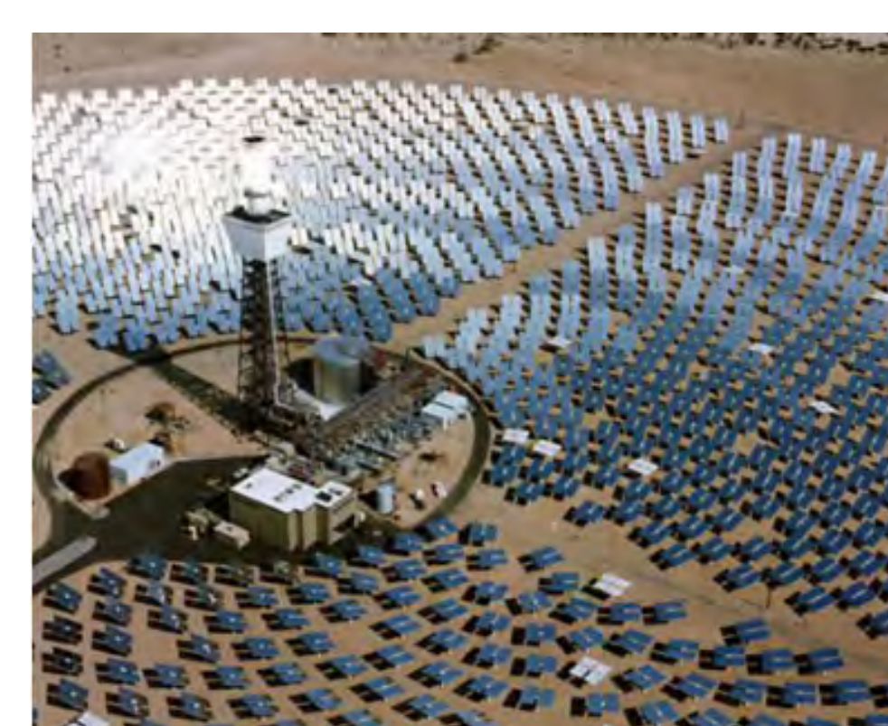
Centrale solaire à concentration Solar 2 de 10 MW, Barstow, Californie, Etats Unis, composée de 1926 héliostats
