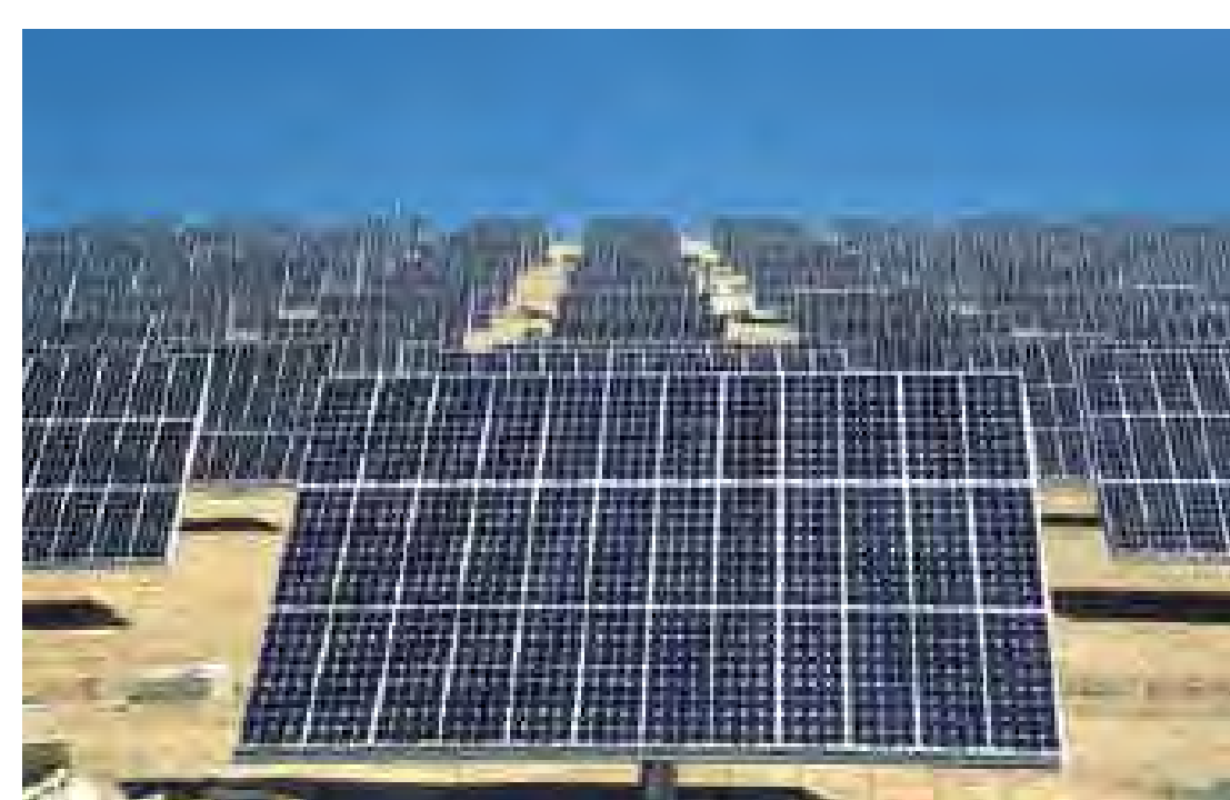
Centrale de 1,18 MWc à Tudela en Navarre, Espagne, constituée de 400 héliostats.
