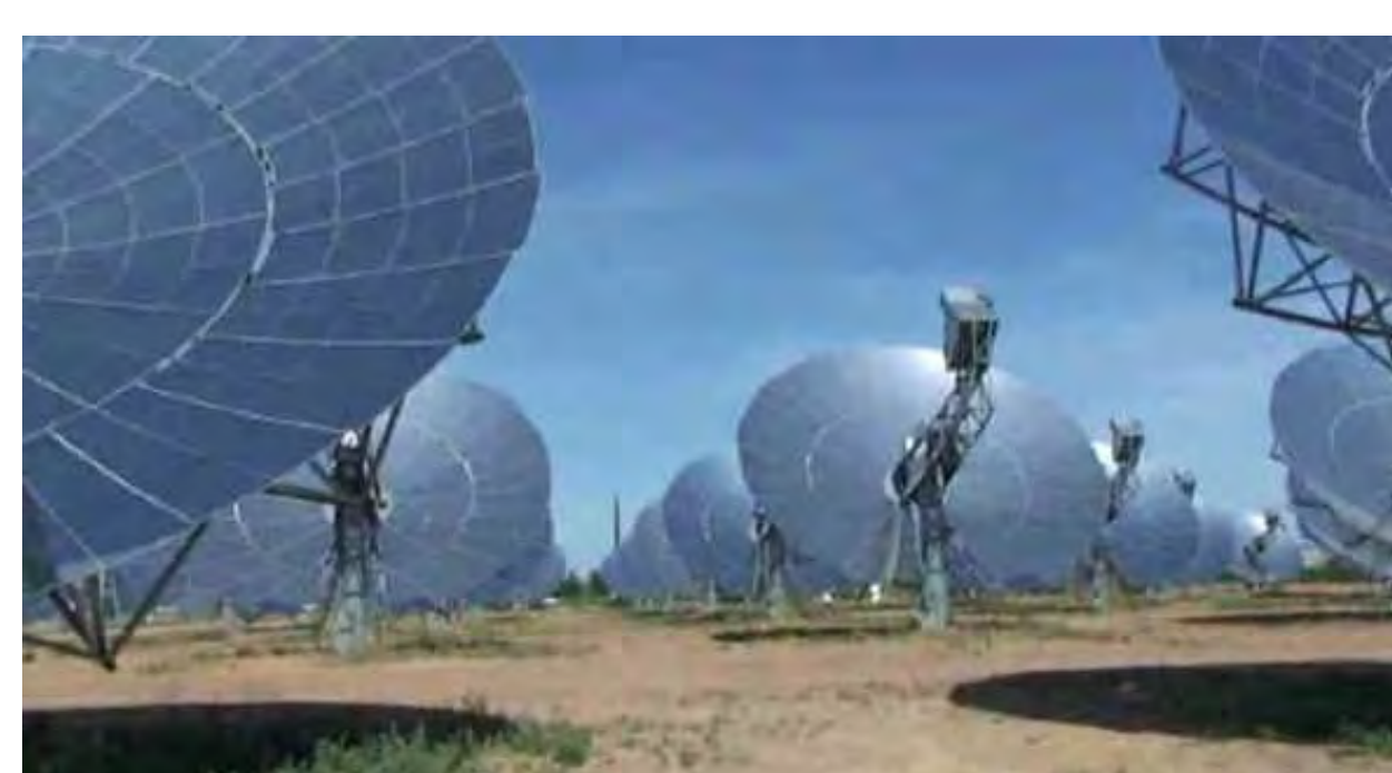
Centrale solaire à capteurs paraboliques "SunCatcher" installés près de Phoenix Arizona en 2010, d'une puissance nominale de 1,5 MW
