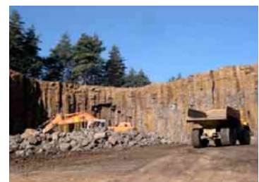
Fourniture de matériaux de construction
