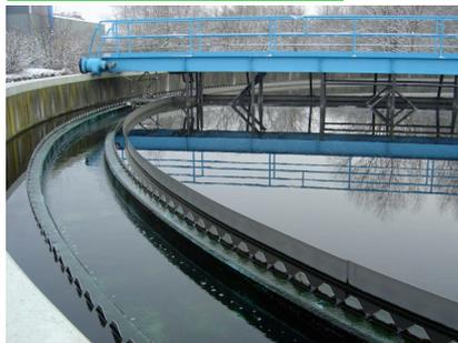
**Clarification :** lors de la dernière étape du traitement, les floccs décantent dans un bassin et sont récupérés sous forme de boues. Une partie de celles-ci sera réinjectée dans le bassin des boues activées pour réensemencer celui-ci ; l'autre partie ira à l'incinérateur ou à la décharge, ou encore, sera revalorisée en agriculture sous forme d'engrais. L'eau épurée est quant à elle rejetée dans le milieu naturel.
