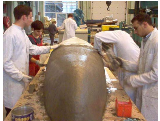
Application du béton
