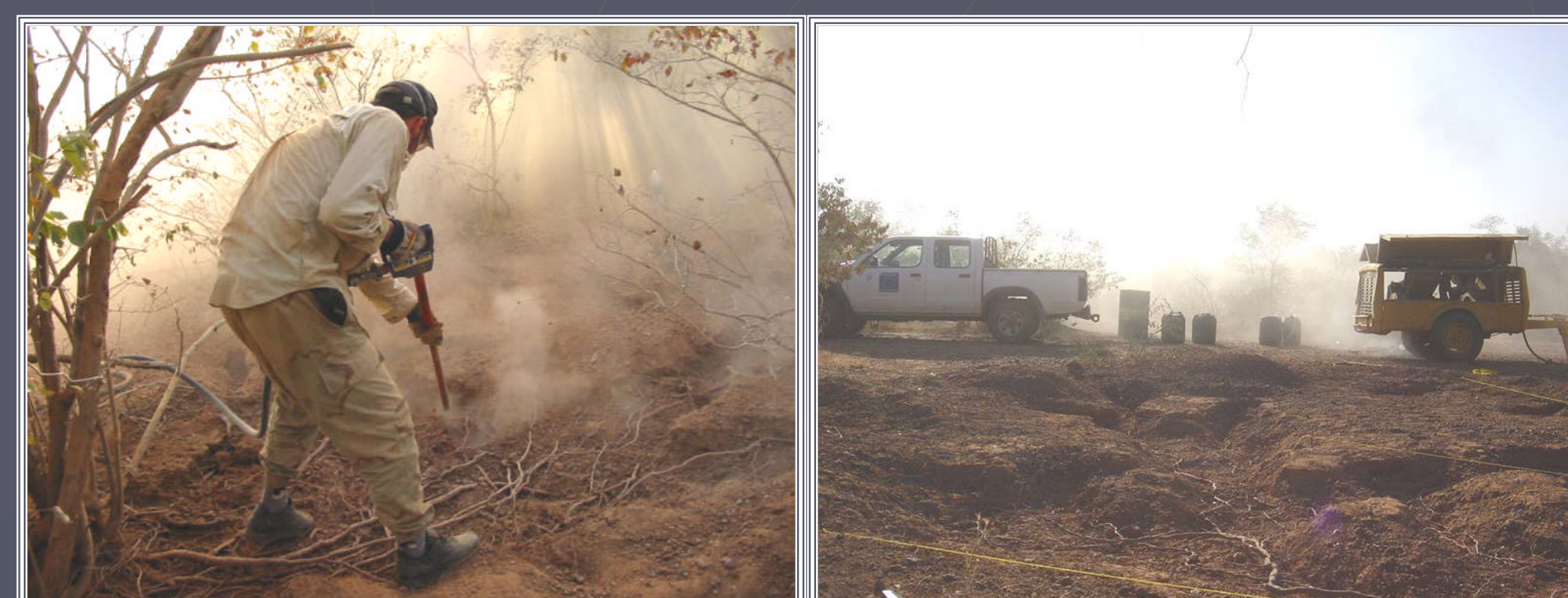
Utilisation d'air comprimé pour le dégagement des systèmes racinaires
