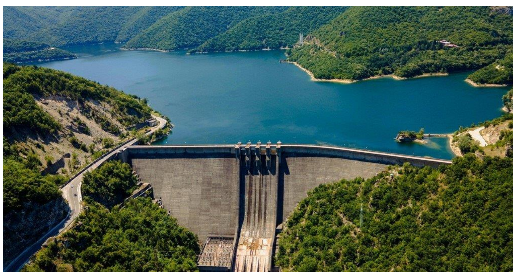
Figure 1 : Barrage de haute chute
